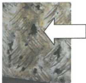
Obr. č. 12. Sklopný nášlapný schod zadního pravého kola – totálně prorezivělý Pohled z vnitřní strany
